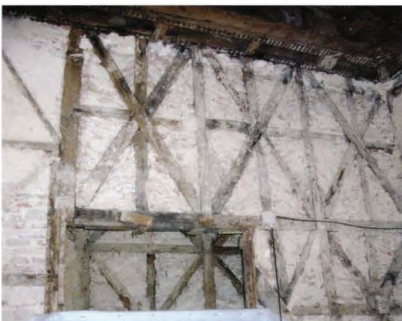
Fig. 4 - Parede em frontal antes da intervenção
