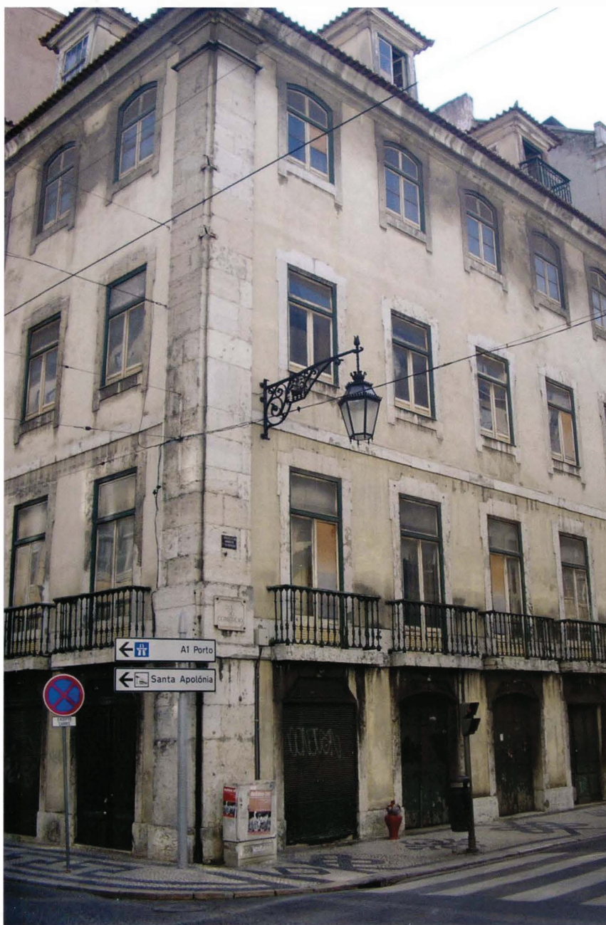
Fig. 1 – Edifício Pombalino em estudo
